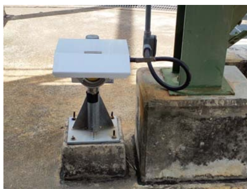
รูปที่ 3.49 Gas Detector
