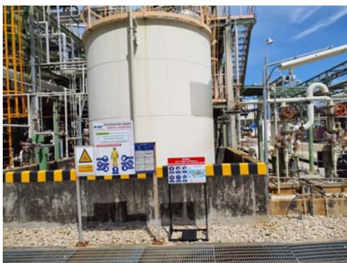
รูปที่ 3.40 คันคอนกรีตบริเวณถังเก็บสารเคมี
