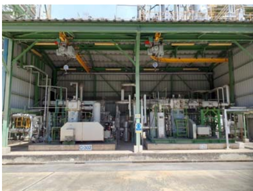
รูปที่ 3.4 Flash Gas Compressor (C-222)
