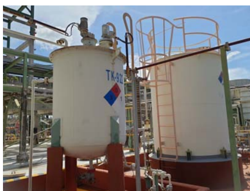
รูปที่ 3.44 คั่นคอนกรีต บริเวณถังเก็บกากโซเดียมไฮดรอกไซด์ (TK-922)
