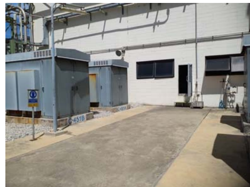
รูปที่ 3.22 อุปกรณ์ลดระดับเสียง (Sound Enclosure Cover Equipment)
