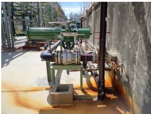
รูปที่ 3.8 Control Valve
