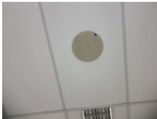
รูปที่ 3.47 ระบบ Acoustic Alarm
